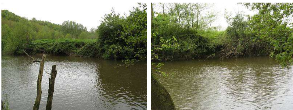
Erosion des berges à Sainte-Pexine (Source : BRGM)
