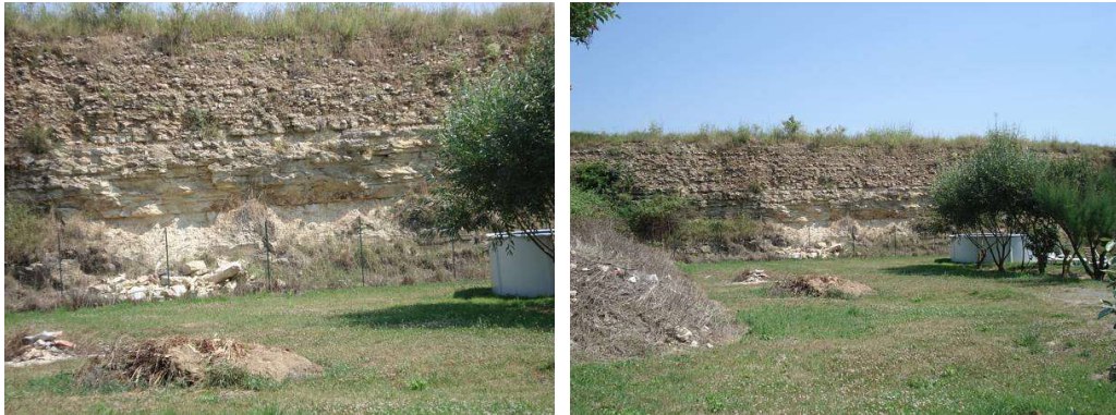
Eboulement/chutes de blocs à Chaillé-les-Marais
