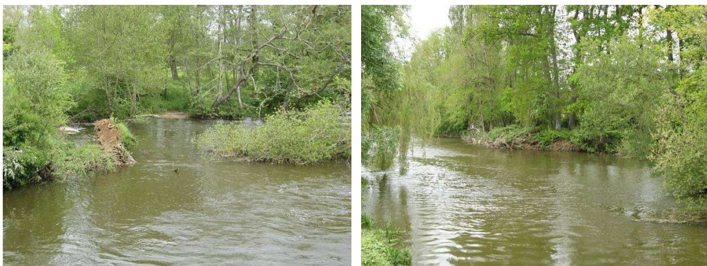
Erosion des berges à Moutiers-sur-le-Lay
